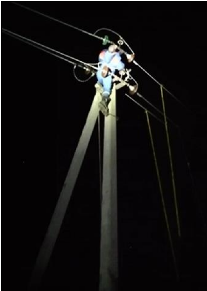
Опора № 37 ВЛ 10 кВ 1004 от ПС Черкутино
