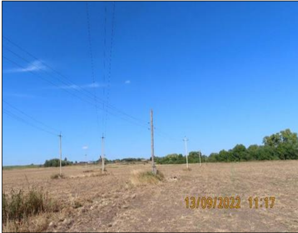
Место пересечения двух ВЛ. Пролет опор № 40-41 ВЛ 10 кВ № 1004 ПС Черкутино и опор № 83-84 ВЛ 10 кВ № 1003 ПС Черкутино
