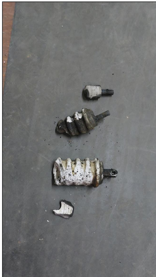
Изоляторы линейного разъединителя ЛР-1, демонтированные электромонтёром до несчастного случая
